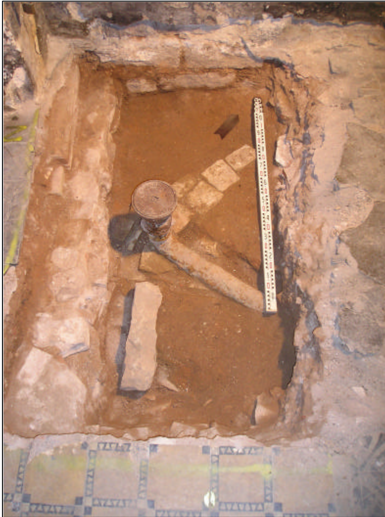
Sondeig 5: detall del tub del dipòsit de benzina u.e.5002 i de la solera de la claveguera u.e.5003.
